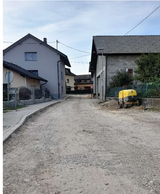
Gradbena dela na Čolnarski ulici.
