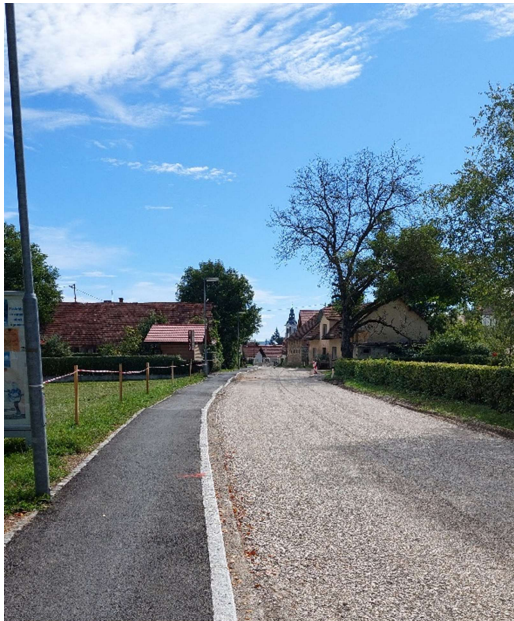
Gradbena dela na cesti Banija.
